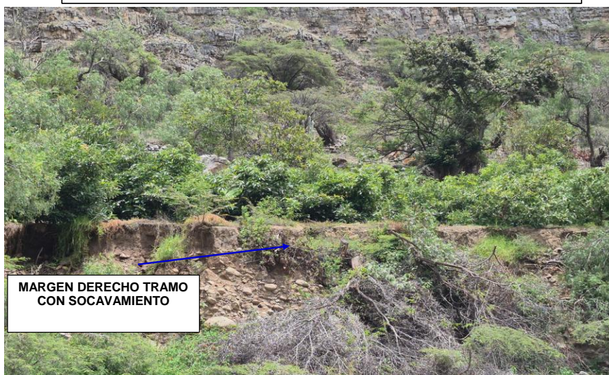
FIGURA N°03: EN LA TEMPORADA DE MAXIMAS AVENIDAS, LA QUEBRADA EROSIONA EN MARGEN DERECHA.
